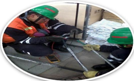
➤ Reparación de mecanismo de seccionador en celdas de subestaciones
